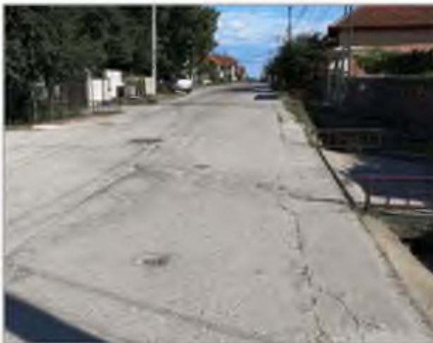
Figura 2.27. Străzi din beton în stare degradată/ balast (Str.Gheorghe Tătărăscu).
